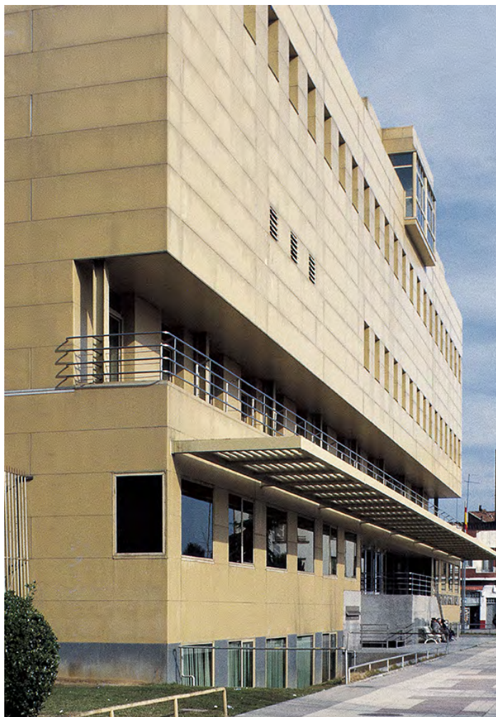
Alejandro de la Sota: edificio de Correos y Telecomunicaciones. León, 1981-1984. Cortesía de Fundación Alejandro de la Sota
