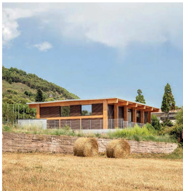
Josep Ferrando, Pedro García, Mar Puig, Manel Casellas: Moià Fire Station, Barcelona, 2020. Photo: Adrià Goula
