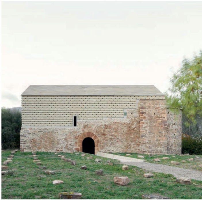
Sebastián Arquitectos: Rolling Stones. Restauración da ermida de San Juan de Ruesta, Huesca, 2021. Foto: Iñaki Bergera
